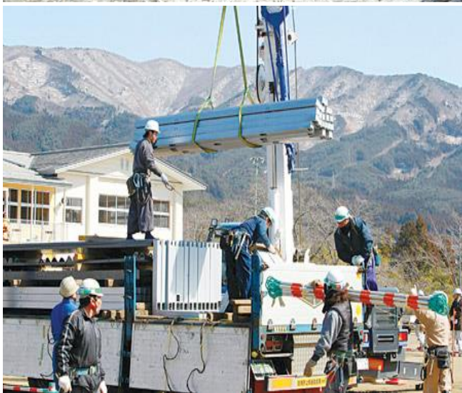
Ảnh: Công nhân làm việc trên công trường
